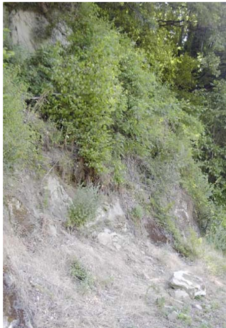
Chute d'un bloc rocheux molassique d'un volume de 50 litres environ, le long de la RD 16 à la sortie de Vanchy
