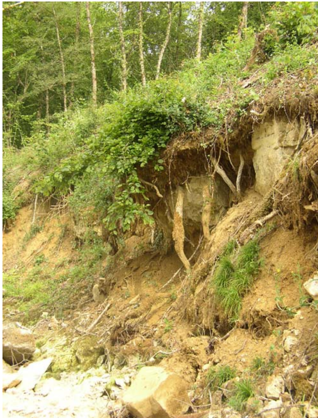
Affouillement de berge (photo prise sur le ruisseau de la Fontaine des Malades)
