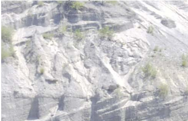
Ravinement au niveau de la carrières du Crêt des Marches
